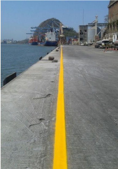
Cais de Capuaba 201 e 202 – Vista Geral Cabeços com difícil operação
