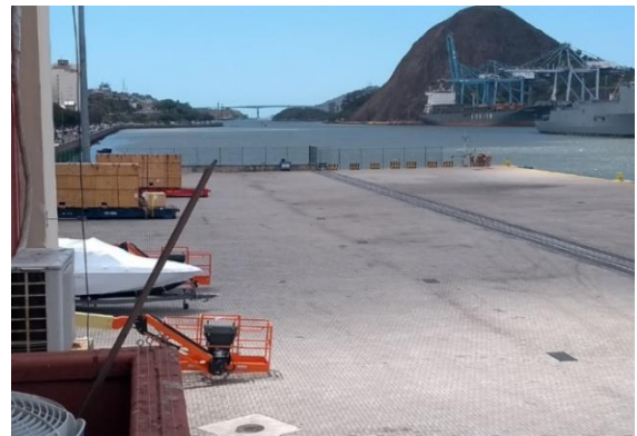
Pavimentação do berço 101
