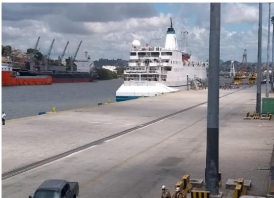
Pavimentação do berço 102
