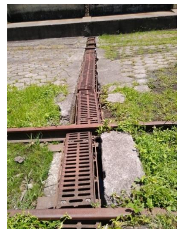
Substituição de canaletas
