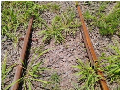
Nivelamento de trilho
