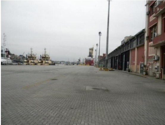
Pavimentação dos berços 101 e 102
