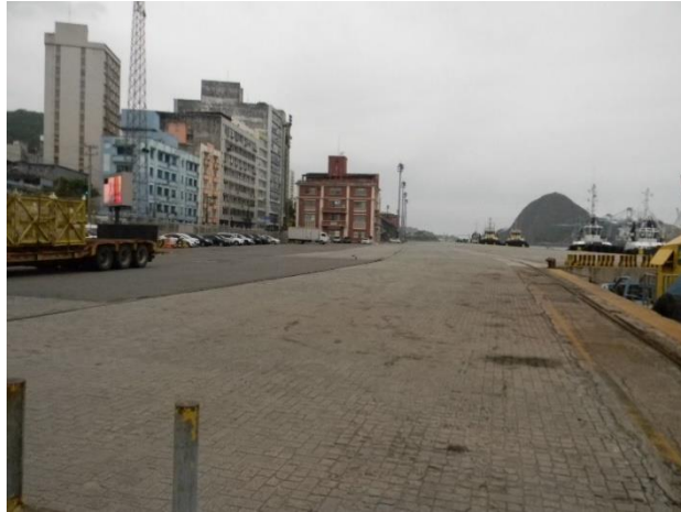
Pavimentação do berço 103
