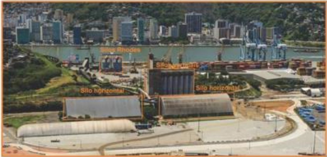
Armazéns mostrado em primeiro plano
